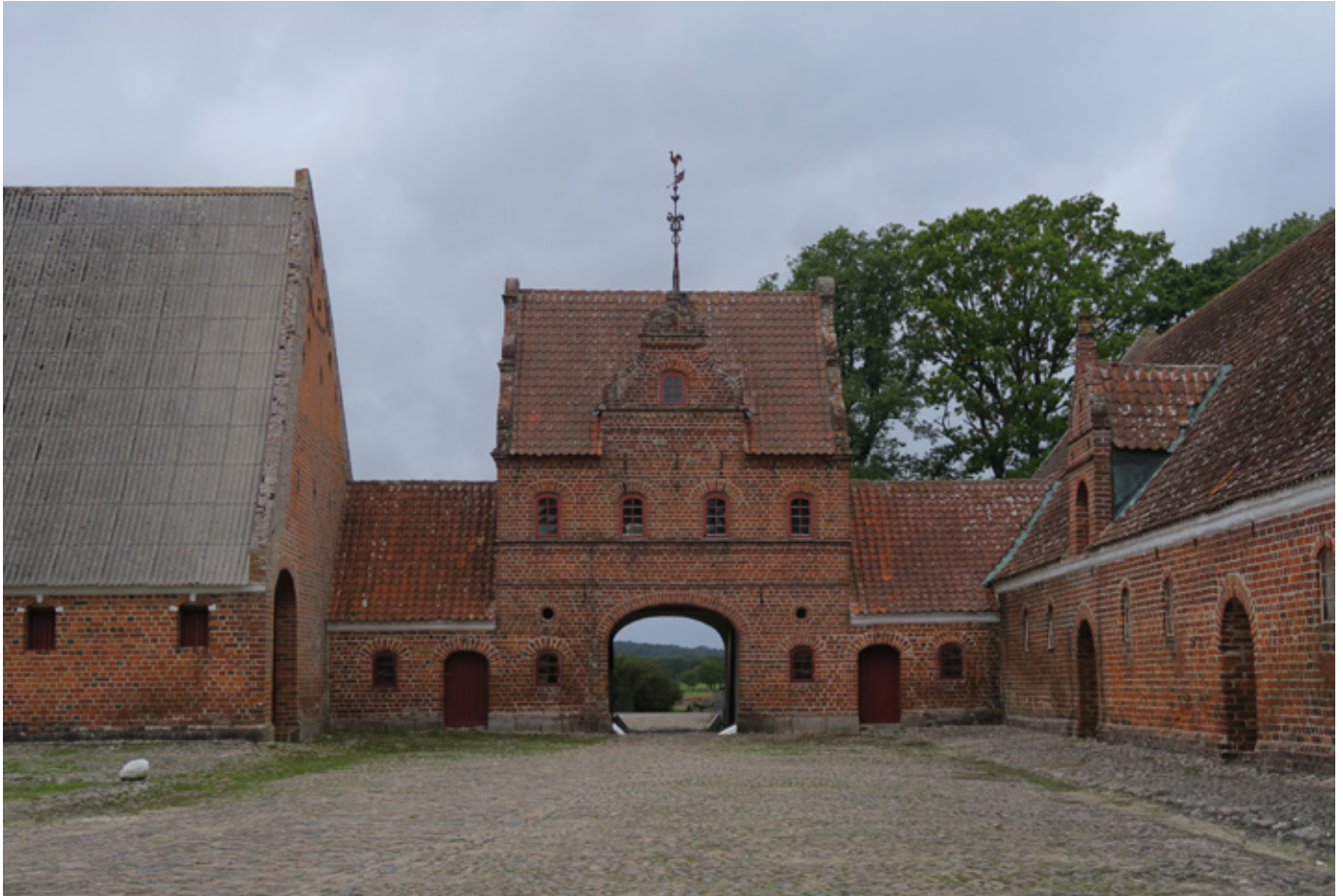
Herregårdens renaissancepræg kommer tydeligt til udtryk i portbygningernes rundbuede vinduer og svungne gavle, mens de store eternittagflader svækker helhedsindtrykket.
